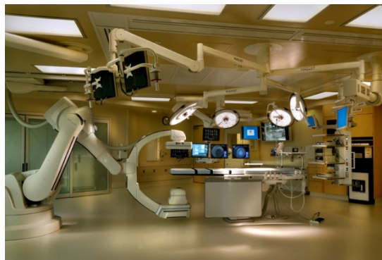
图 14 带空气幕送风装置的综合手术室
