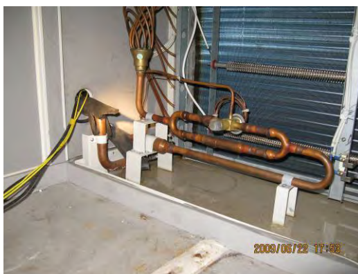
图 2.3.4 空调机组表冷器和电加热器
