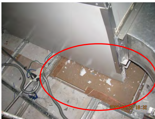
图 2.3.8 顶板密封不严
