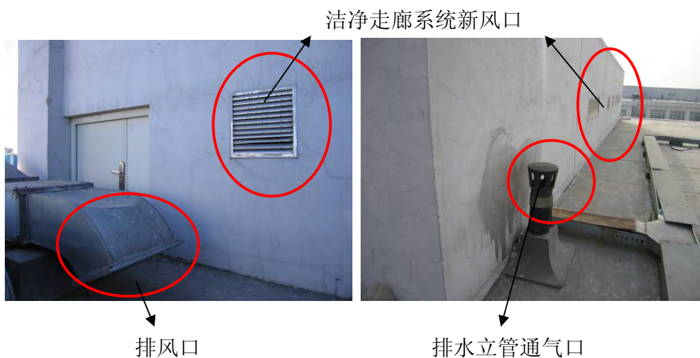
图 2.2.1 新风口与排风口过近
