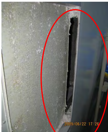
图 2.3.6 病房排风高效过滤器安装位置不合理
