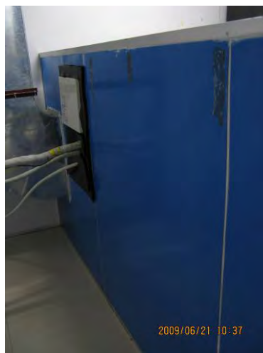
图 2.3.2 冷凝水排水管未作返水弯
