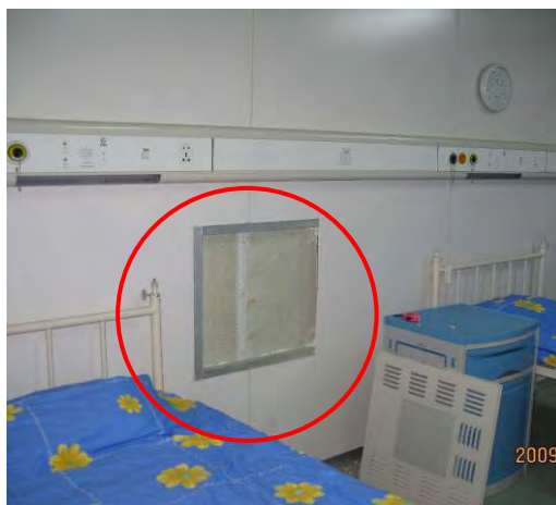
图 2.3.7 病房排风高效过滤器安装位置过高
