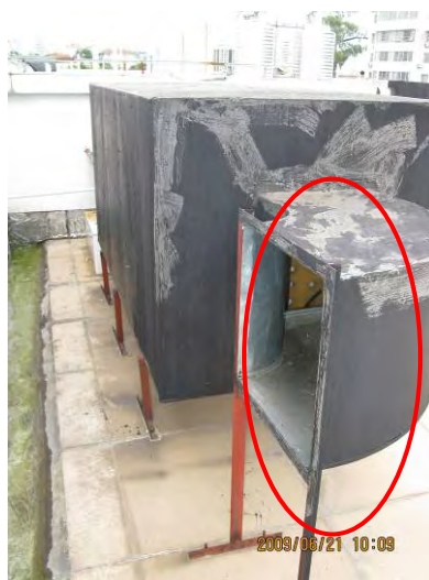
图 2.3.5 某传染病隔离病房屋顶排风机
